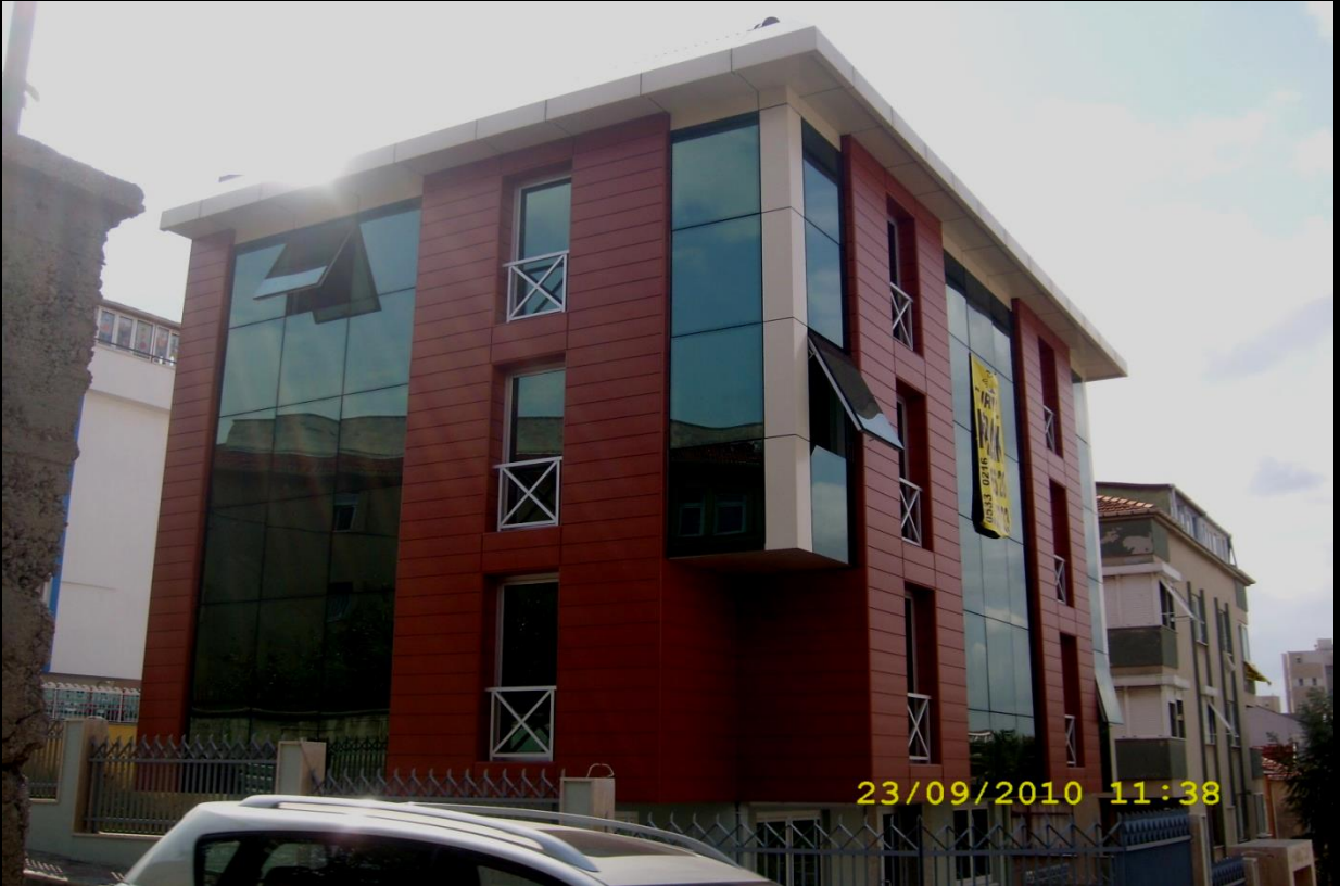
Cebeci İnşaat – Ataşehir
