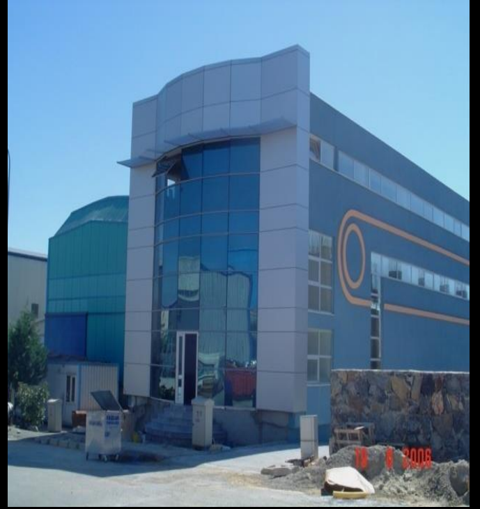
Dolunay Elektrik - GOSB
